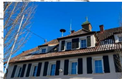
Sirene auf dem Dach des Rathauses der Gemeinde Ratshausen
