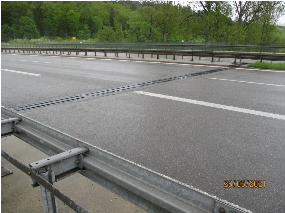
Bild: Bestehende Übergangskonstruktion Fahrtrichtung Dußlingen, Quelle: Sven Hoppe-RP
