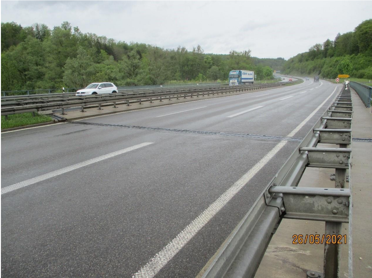
Bild: Bestehende Übergangskonstruktion Fahrtrichtung Tübingen, Quelle: Sven Hoppe-RPT
