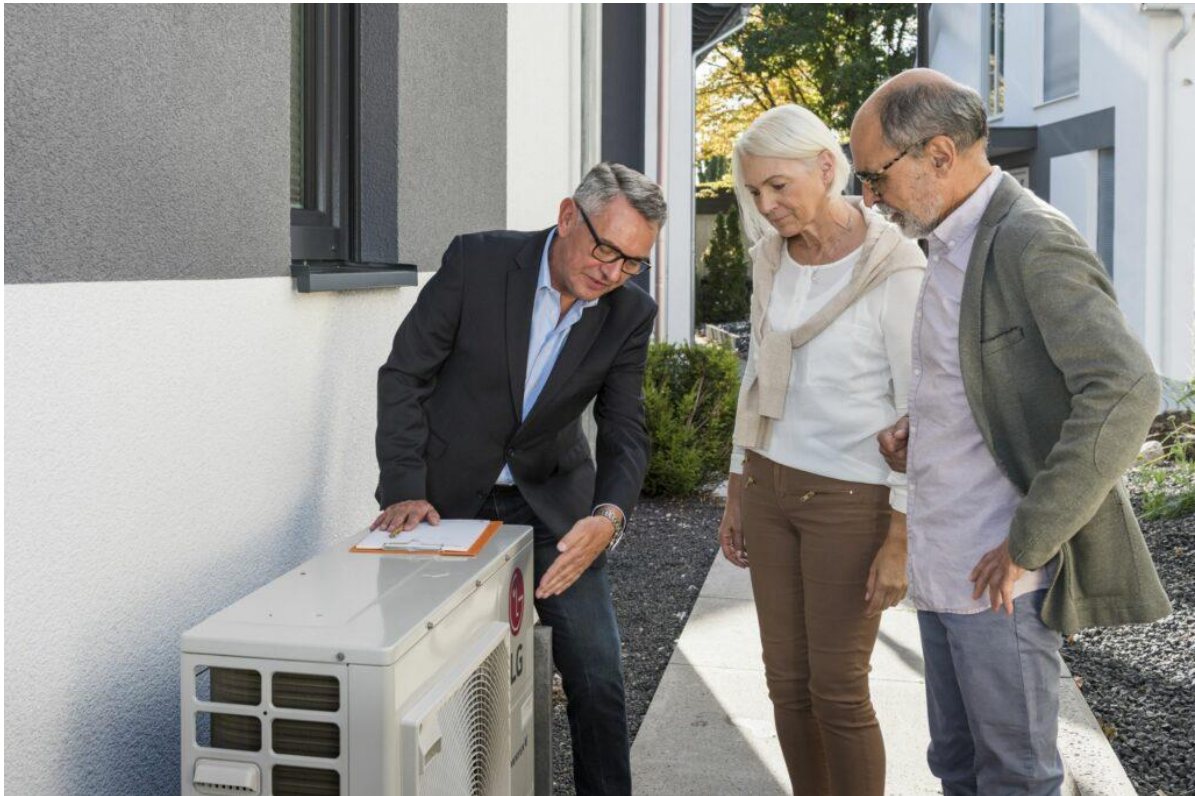
Wärmepumpen müssen richtig geplant werden, sonst können hohe Stromkosten drohen. Foto: Zukunft Altbau
