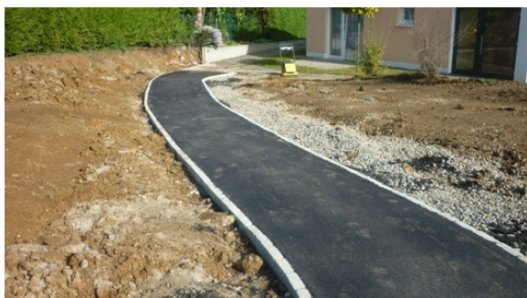
Asphaltierung der Wege in der KW 42 – Ende Oktober 2012
