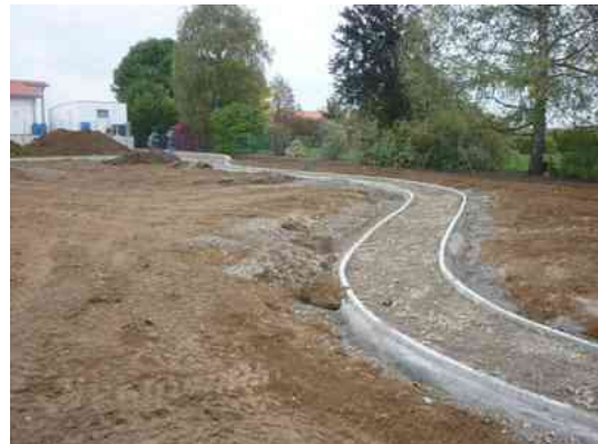
Beginn der Randsteinsetzung und Gelände- modellierung, Stand: 01.10.2012
