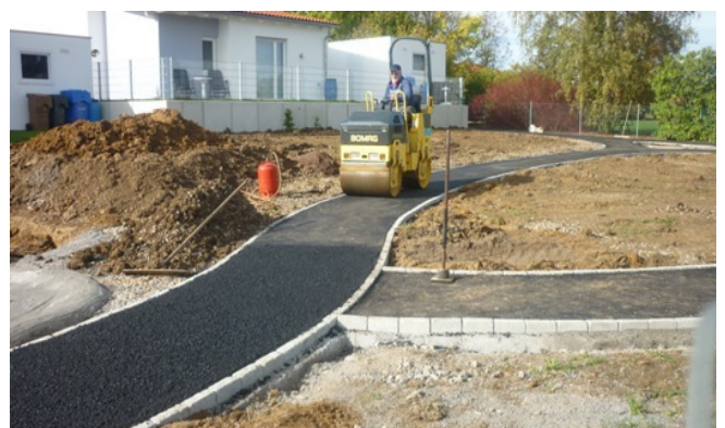
Asphaltierung der Wege in der KW 42 – Ende Oktober 2012
