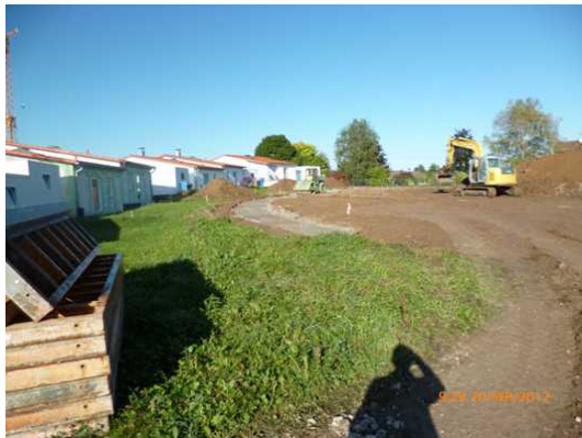
Fortschritt der Erdarbeiten und erste Wegeführungen, Stand: 20.09.2012
